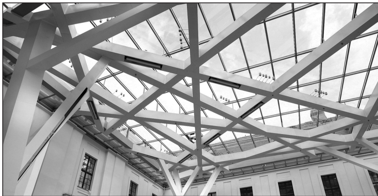
Blick frei: Ganz aus Glas ist das neue Dach des Innenhofes vom Jüdischen Museum Berlin, das von Star-Architekt Libeskind entworfen wurde. Fotos: dpa
