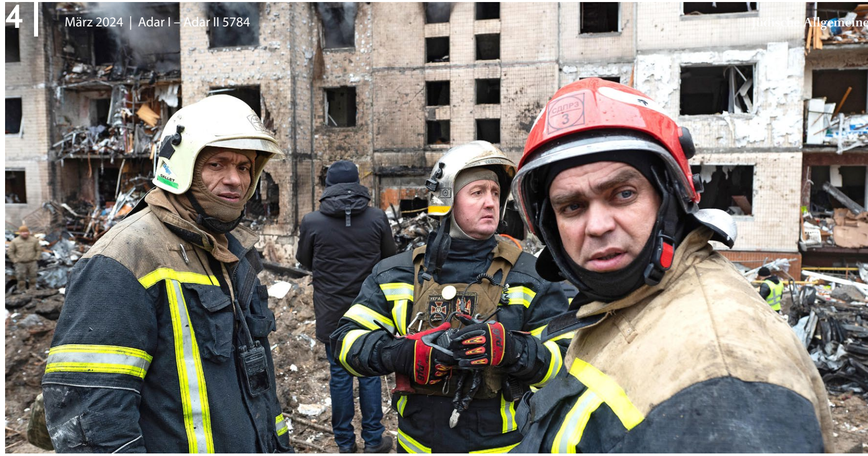
Ein schwer beschädigtes Wohnhaus nach einem russischen Raketenangriff Anfang Januar in Kyiv Foto: picture alliance / Anadolu Жилой дом в Киеве, сильно повреждённый в результате российского ракетного удара в начале января
