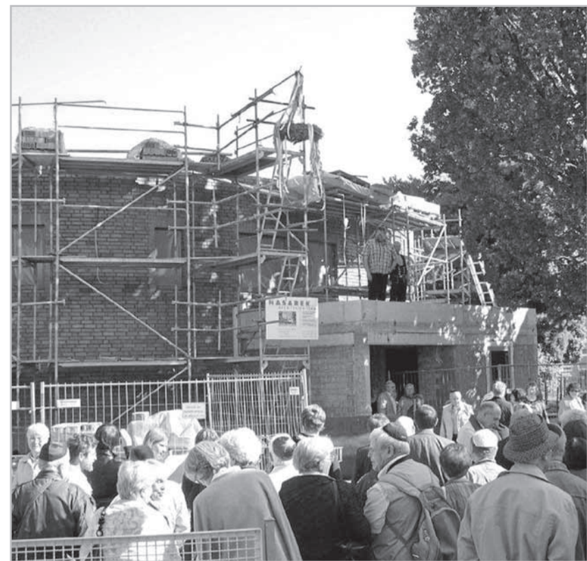
An historischer Stelle: Richtfest für die liberale Synagoge in Hameln Foto:Gemeinde
