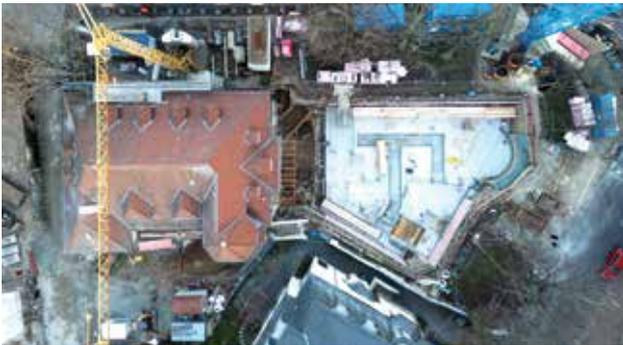
Stand Februar 2023 – Die Bodenplatte des Neubaus wurde betoniert.
